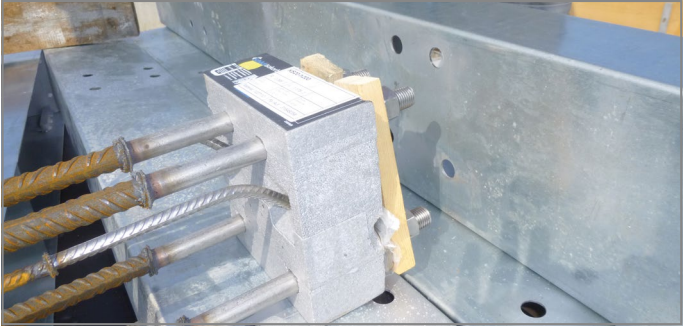
Abb. 32: Verwendung einer Alu-Schalungshilfe
