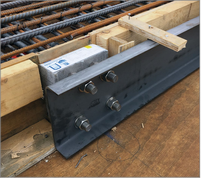
Abb. 34: Verwendung einer Stahl-Schalungshilfe
