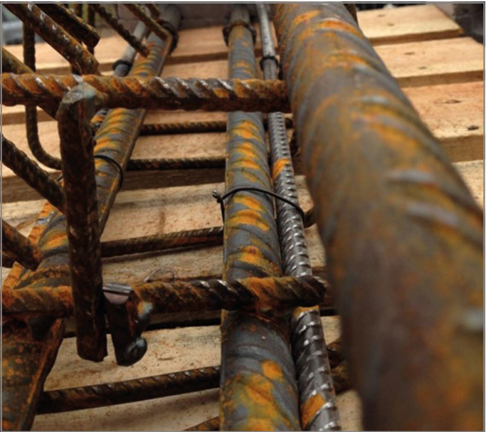
Abb. 43: Angeschweißter Steg zwischen unterer und oberer Bewehrung
