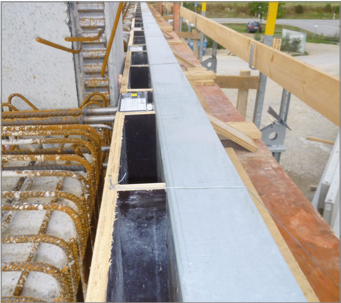
Abb. 33: Alu-Schalungshilfe in eingebautem Zustand
