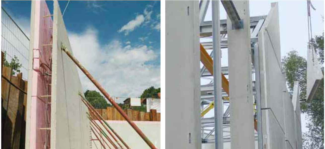
Abb. 5-6a u. b: Kerngedämmte Sandwich- und Doppelwände mit dem Schöck ComBAR®-Thermoanker, links vor der Befüllung mit Ortbeton, rechts nach der Befüllung als Vollfertigteil
