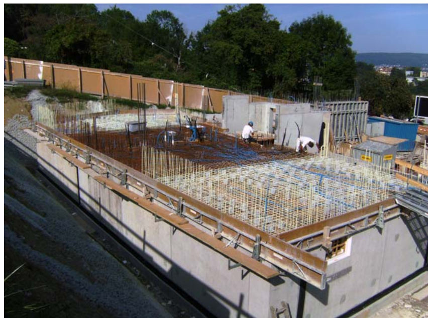
Abb. 4-3a u. b: Mit Schöck ComBAR® wurden sowohl Wände als auch Geschossdecken bewehrt.
