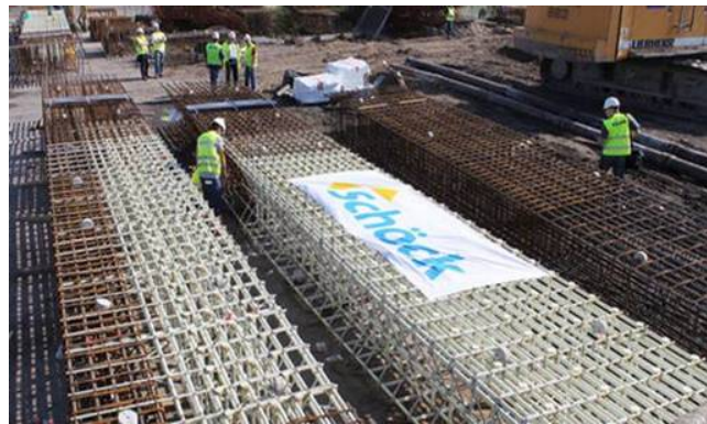
Abb. 5-5a u. b: Schlitzwände für den Autobahntunnel unter der Weichsel, Air-Sea Link Gdansk, Polen, 2012
