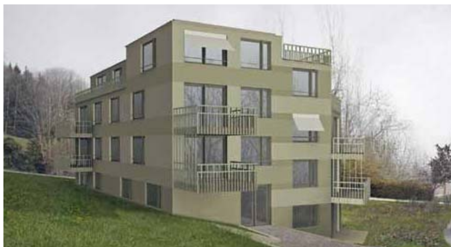
Abb. 4-1: Das am südlichsten Siedlungsrand gelegene Grundstück wurde nach umfassenden baubiologischen Untersuchungen von der Stadt Zürich zur Verfügung gestellt.
