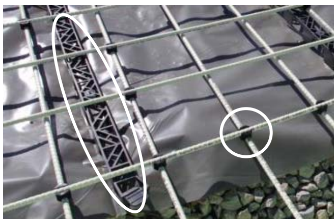
Abb. 3-2: Bodenbewehrung mit Gitter aus Glasfaserstäben (untere Lage); konventionelle Abstandshalter vom Boden aus Kunststoff (Ellipsenmarkierung) und spezielle Klemmverbinder des ComBAR®-Systems aus Kunststoff (Kreismarkierung)
