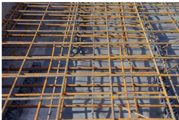
Abb. 3-1: Bodenbewehrung mit Betonstahlgitter (zweilagig)
