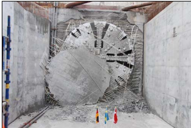
Abb. 5-4: Durchbruch der Tunnelbohrmaschine, City Tunnel, Malmö, Schweden, 2007
