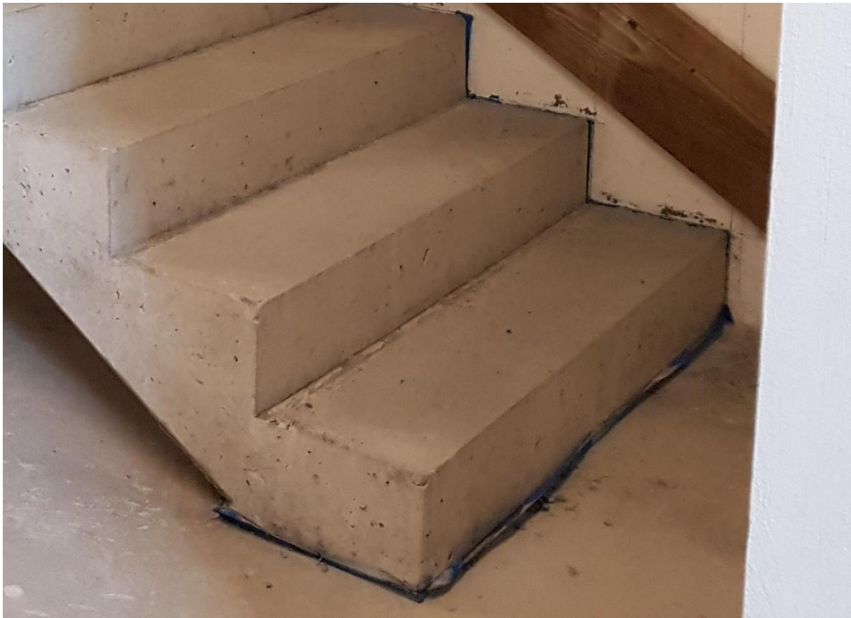
Abbildung 7: Fugenplatte Schöck Tronsole® Typ L-420 mit bauüblichem Anpressdruck eingebaut, sowie Auflagerung Fußpunkt Referenztreppenlauf mit Elastomerlagern der Schöck Tronsole Typ T-V8-L1300
