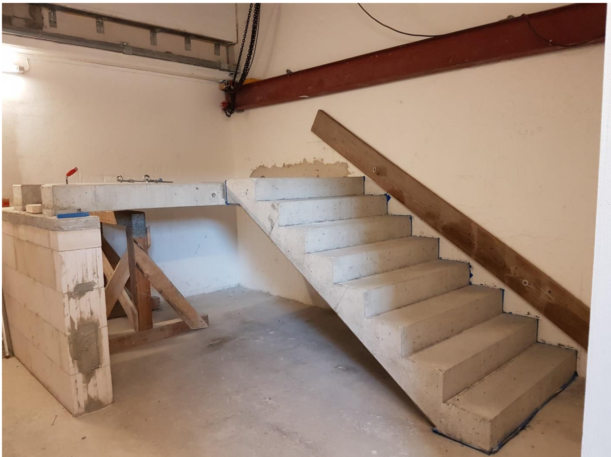
Abbildung 6: Entkoppelter Referenztreppenlauf, entkoppelt mit Schöck Tronsole® Typ T-V8-L1300
