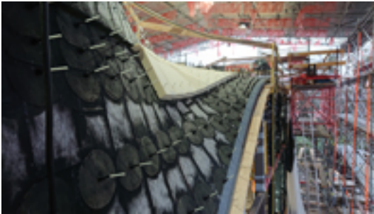
Für das energieeffiziente Dach sorgen die 14 Zentimeter Wärmedämmung sowie der Fassadenanker Schöck Isolink, der Wärmebrücken minimiert. Foto: Marén Kupke
