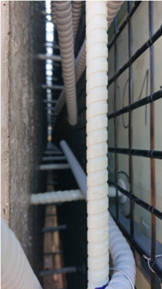
Um Schöck Combar als Bewehrung der Wandecken einzusetzen, mussten die erforderlichen Biegeradien mit den Anforderungen der sehr schlanken Wandaufbauten in Einklang gebracht werden. Foto: Marén Kupke
