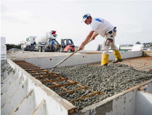
Das Betonieren der Vorsatzschale. Foto: Schöck Bauteile GmbH
