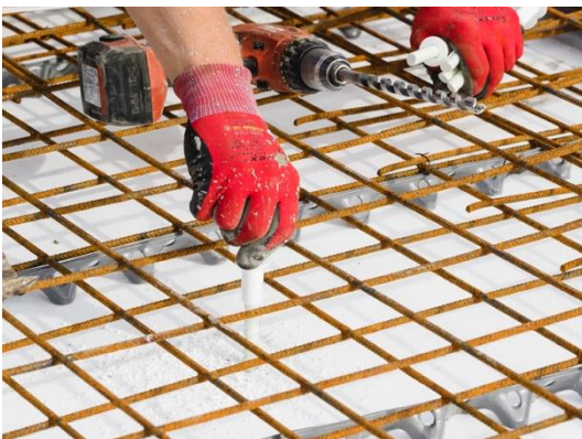
Der Schöck Isolink Typ C-SH für aufgesetzte Vorsatzschalen wird mit einer Tiefe von mindestens 6 cm in die Dämmung gesetzt. Foto: Schöck Bauteile GmbH
