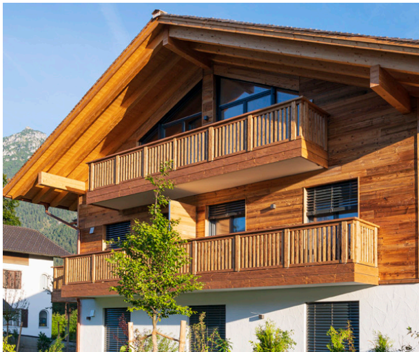
Die kleinen Balkone haben eine Auskrragung von 1,20 m bis zu 1,90 m. Fotos: Schöck Bauteile GmbH
