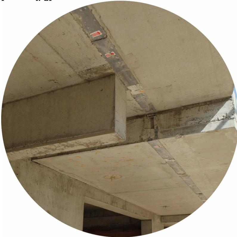
*Der Schöck Isokorb bietet dem Architekten nicht nur eine sehr hohe Gestaltungsfreiheit, sondern er vermeidet als tragendes Wärmedämmelement Wärmebrücken an auskragenden Bauteilen und damit Bauschäden. Foto one fine day.*
