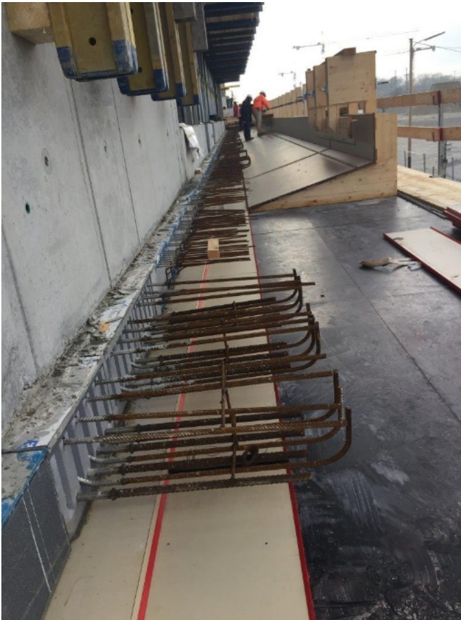
Wegen der speziellen Anforderungen wurden etliche Isokorb Elemente in Sonderausführung verbaut. Foto: Schöck Bauteile GmbH, Abdruck honorarfrei.
