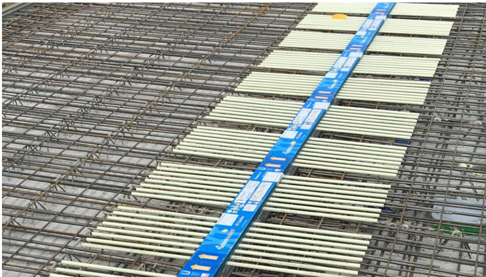
[Eingesetzter Isokorb.jpg]
