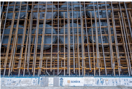
Die Hohlkörper, die das Gewicht der Balkone reduzieren, sind zwischen den Bewehrungslagen der Stahlbetonplatten platziert. Foto: Schöck Bauteile GmbH
