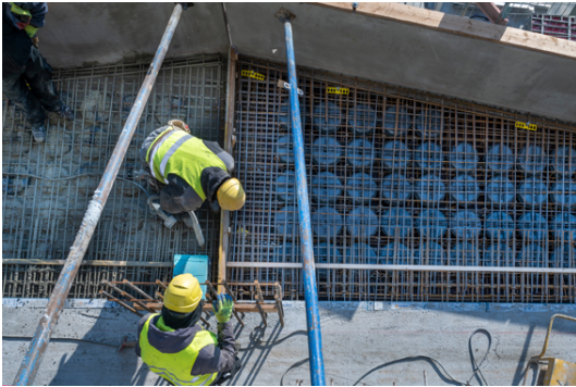
Die Balkone werden im Ortbetonverfahren erstellt und sind mit Schöck Isokorb an die Geschossdecke angeschlossen. Zwischen den einzelnen Platten sorgt Schöck Stacon für eine belastbare Verbindung. Foto: Schöck Bauteile GmbH
