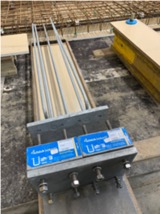
Bei der Befestigung der Balkone am Bestandsgebäude kam der Schöck Isokorb T Typ S zum Einsatz. Foto: Schöck Bauteile GmbH
