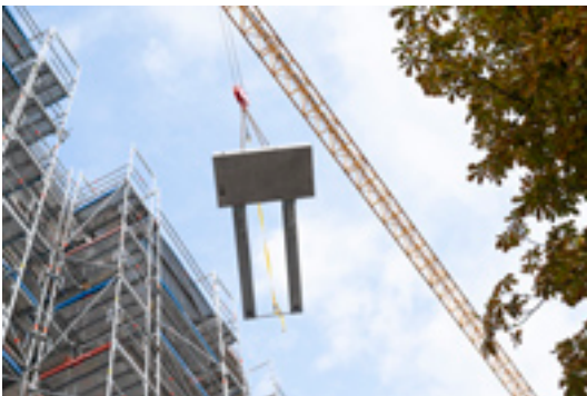
Für das Projekt View180 wurden pro Tag zwei Balkone im Betonfertigteilwerk produziert. Foto: Schöck Bauteile GmbH
