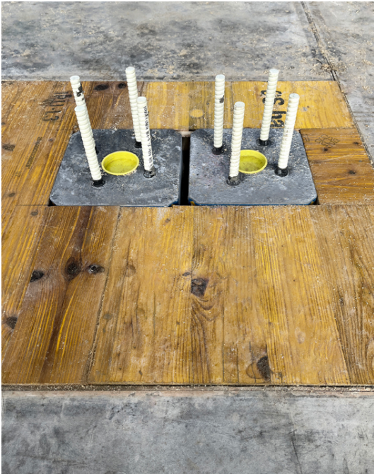
Die zwei nebeneinandergesetzten Sconnex Typ P in der Holzschalung vor der Deckenbetonage.
