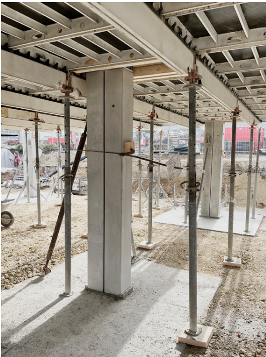
Um die Lasten zuverlässig abzutragen, wurden zwei quadratische Stützen nebeneinandergesetzt und einzeln mit Sconnex Typ P angeschlossen. Zwischen den beiden Stützen verläuft eine Fuge von exakt einem Zentimeter.
