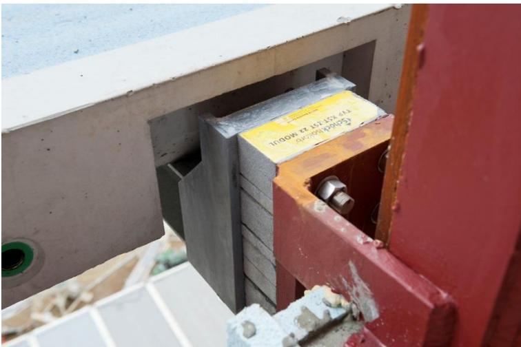
*Für die Montage und die thermische Entkopplung kam der Schöck Isokorb Typ KST zum Einsatz. Foto: Schöck Bauteile GmbH, Abdruck honorarfrei.*
