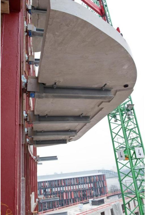
*Für die Montage der Balkone konnten die freigelegten, durchgehenden senkrechten Stahlträger des tragenden Stahlskeletts genutzt werden. Foto: Schöck Bauteile GmbH, Abdruck honorarfrei.*
