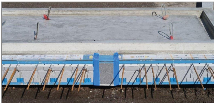
Abb. 58: Schnittkanten mit Panzerband abkleben
