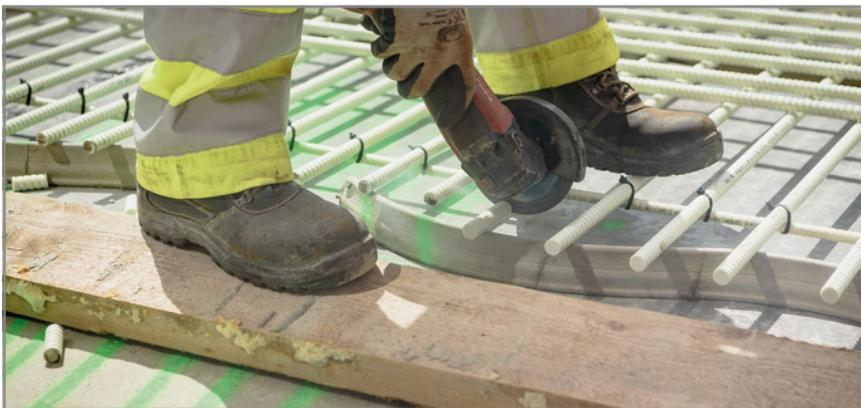
Abb. 3: Leichte Zerspanbarkeit von Combar® unter Querdruck
