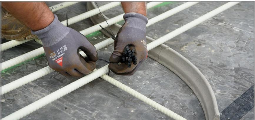
Für die Verbindung von Stäben mit dem gleichen Durchmesser (8 mm und 12 mm) können außerdem Clips von Schöck genutzt werden.
