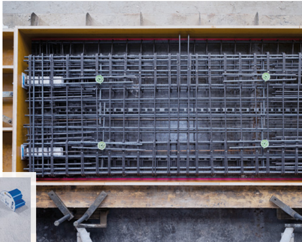
Podesthülse, Trag- und Wandelement (v.l.n.r.). Einfache Podestschalung.
