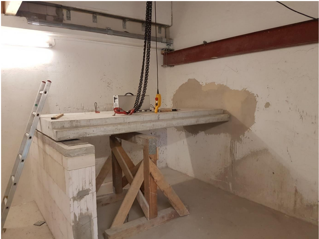
Abbildung 5: Entkoppeltes Referenztreppenpodest Gesamtansicht oben mit Hydraulikstempel zur Aufbringung der Zusatzlasten, unten mit Schöck Tronsole® Typ Q-FV-XL
