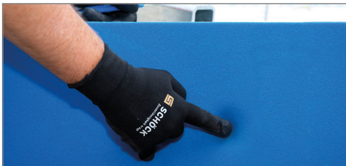
Abb. 33: Aussparung der Podesthülse ertasten
