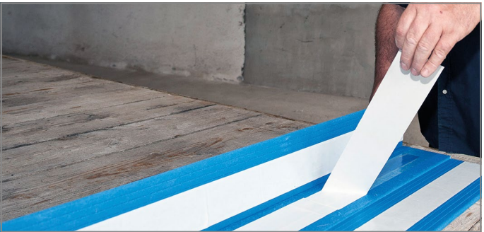
Abb. 104: Schutzfolie von Tronsole® Typ F abziehen
