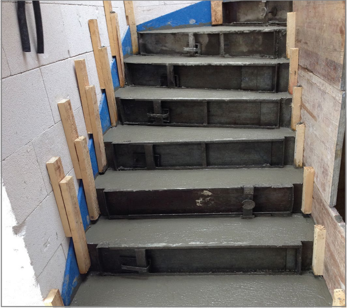
Abb. 131: Treppenlauf betonieren
