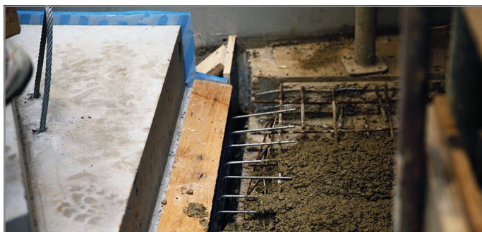
Abb. 97: Anschlussbereich betonieren
