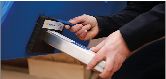
Abb. 74: Geometrie der Brandschutzmanschette ausschneiden
