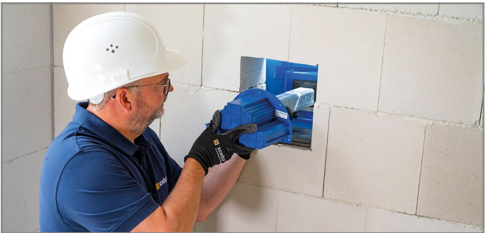
Abb. 43: Tragelement und Wandelement in Podesthülse einfahren
