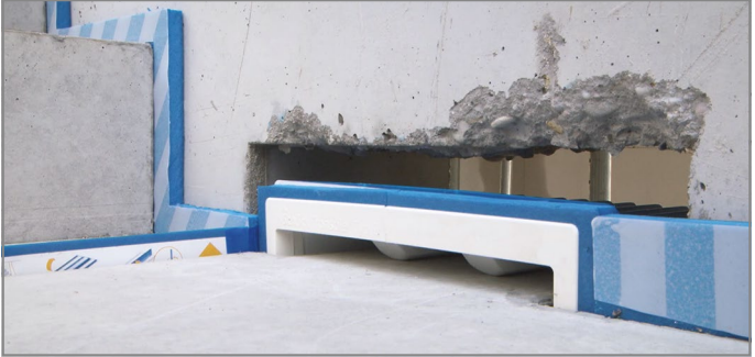
Abb. 57: Wandaussparung vergießen
