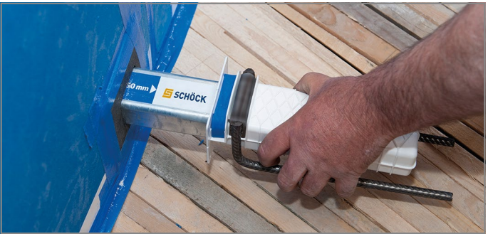
Abb. 69: Laufhülse aufstecken
