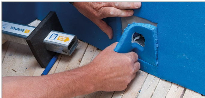
Abb. 65: Ausschnitt für die Brandschutzmanschette entfernen
