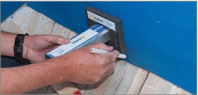
Abb. 63: Brandschutzmanschette auf Fugenplatte Typ L anzeichnen
