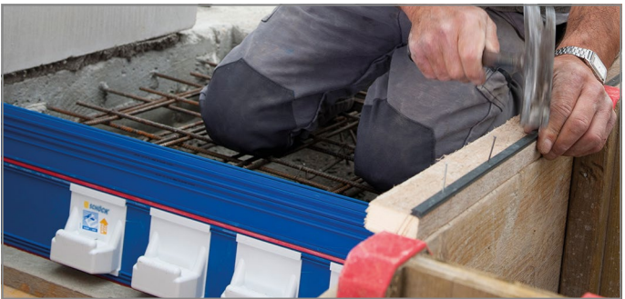
Abb. 90: Obere Nagelleiste anbringen
