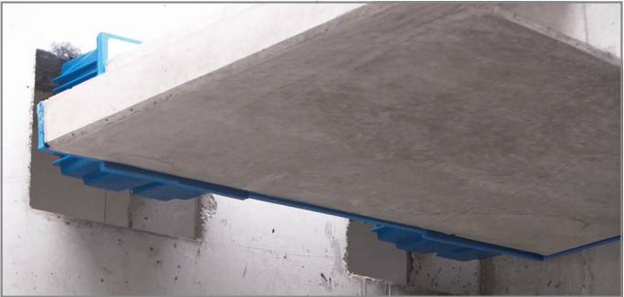
Abb. 53: Treppe mit Tronsole® Typ Z in die Auflagertaschen einführen
