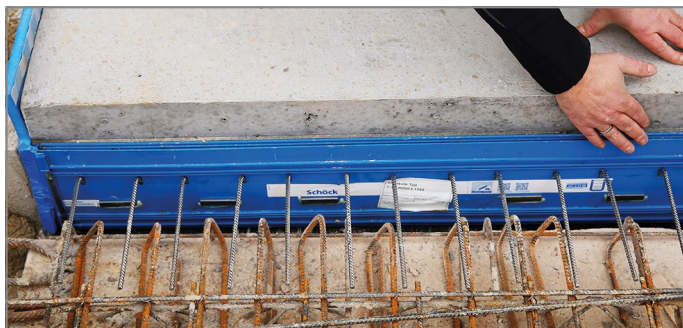
Abb. 96: Treppe einsetzen und stützen
