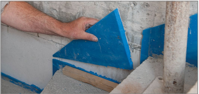
Abb. 132: Tronsole® Typ L mit Überstand abschneiden
