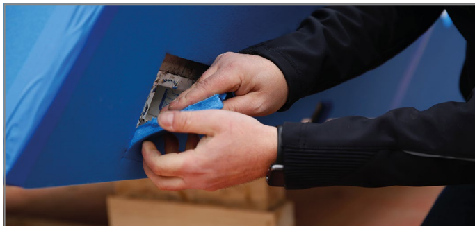
Abb. 75: Ausschnitt für die Brandschutzmanschette entfernen
