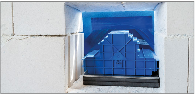
Abb. 49: Wandaussparung vergießen
