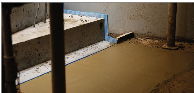
Abb. 98: Anschlussbereich betoniert
