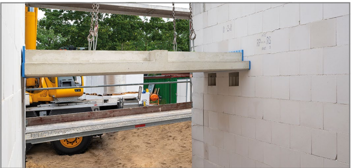
Abb. 38: Podest zwischen den Treppenhauswänden einheben
