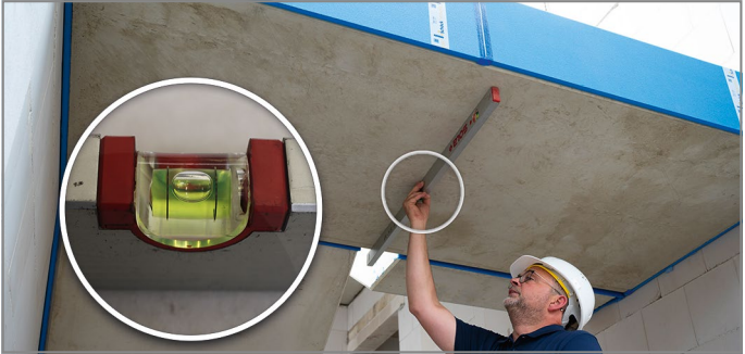
Abb. 48: Podest nach Ablegen der Treppenläufe auf waagerechten Sitz überprüfen
