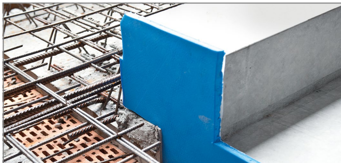
Abb. 144: Oberes Auflager der Treppe kontrollieren
