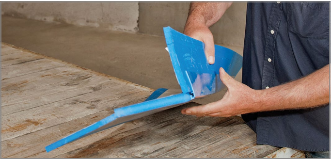
Abb. 103: Clipscharnier von Tronsole® Typ F im Winkel von 90° einrasten
