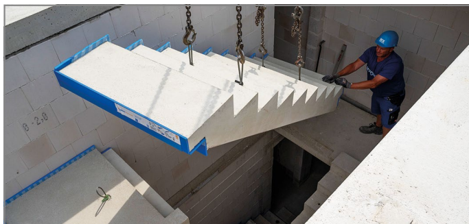
Abb. 47: Treppenlauf einheben
