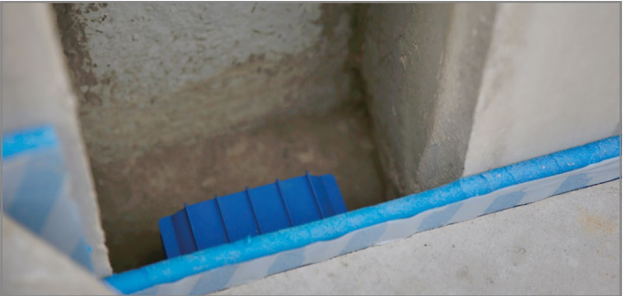
Abb. 85: Aussparung vergießen
