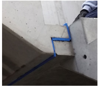
Abb. 3: Blaue Linie zeigt durchgängige Entkopplung
