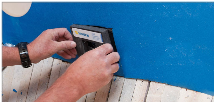
Abb. 66: Brandschutzmanschette einsetzen
