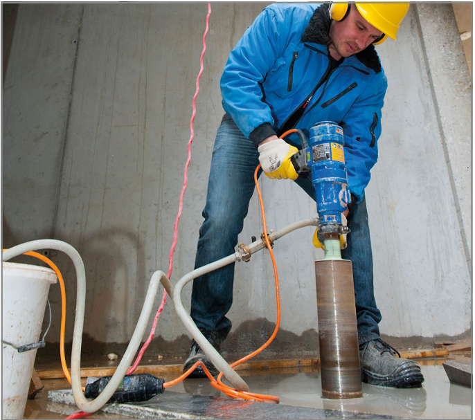
Abb. 114: Kernbohrung mit 100 mm Durchmesser in Bodenplatte setzen
