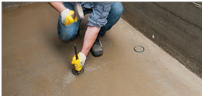
Abb. 115: Kernbohrung ausbrechen
