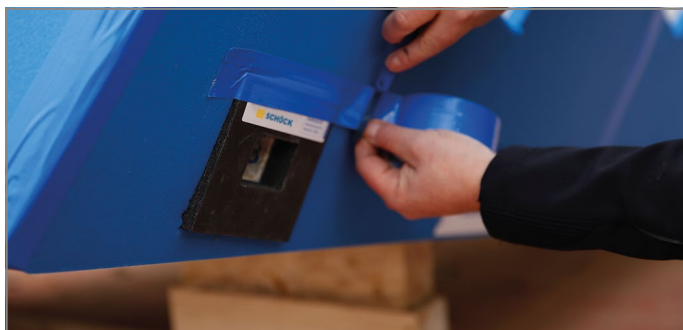
Abb. 76: Brandschutzmanschette einsetzen und abkleben
