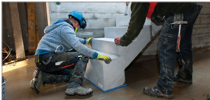
Abb. 121: Treppe absetzen
