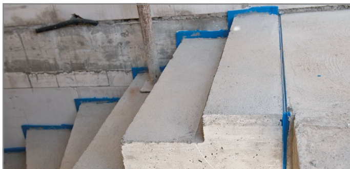
Abb. 134: Gerade Fugenausbildung am Treppenaustritt
