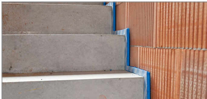
Abb. 145: Überstand der Fugenplatte kontrollieren
