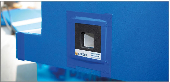
Abb. 37: Brandschutzmanschette einsetzen und abkleben
