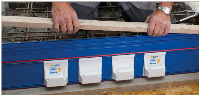
Abb. 91: Obere Nagelleiste in Tronsole® Typ T einklipsen
