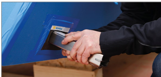
Abb. 77: Tragelement montieren
