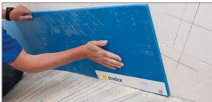
Abb. 129: Tronsole® Typ L aufkleben
