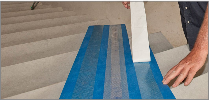
Abb. 109: Schutzfolie von Tronsole® Typ B abziehen
