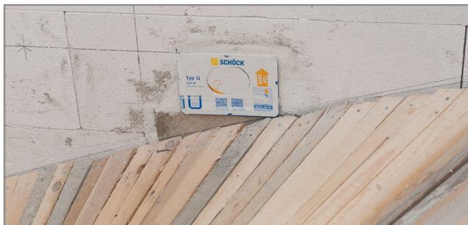
Abb. 59: Wandelement Tronsole® Typ Q in KS-Wand eingemauert
