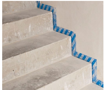
Abb. 5: Blaue Linie zeigt durchgängige Entkopplung
