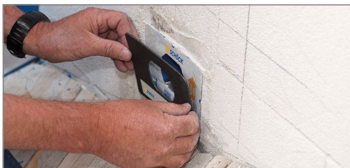
Abb. 61: Brandschutzabdeckung aufkleben
