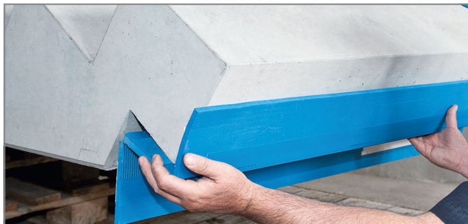
Abb. 105: Obere Schenkel von Tronsole® Typ F ankleben
