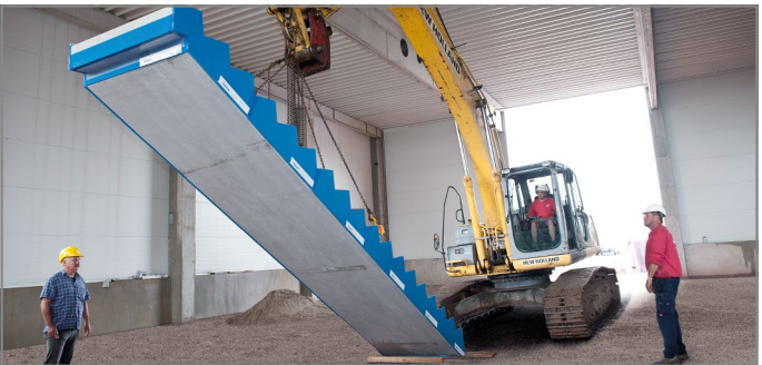
Abb. 143: Vorbereitete Treppe einsetzen
