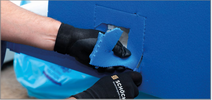
Abb. 36: Geometrie der Podesthülse ausschneiden
