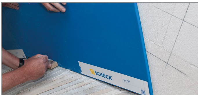
Abb. 124: Unteres Laufprofil von Tronsole® Typ L anzeichnen
