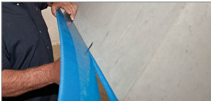
Abb. 111: Überstand von Tronsole® Typ B bündig abschneiden
