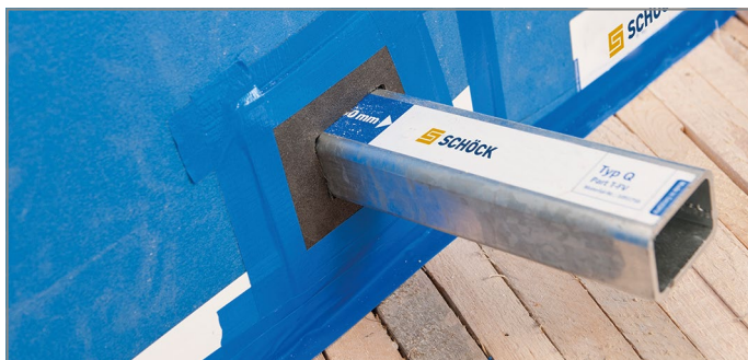
Abb. 67: Trageelement montieren und Brandschutzmanschette abkleben
