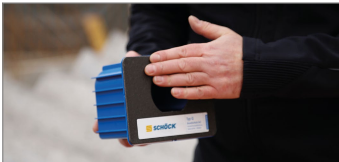
Abb. 78: Brandschutzabdeckung auf Wandelement aufkleben
