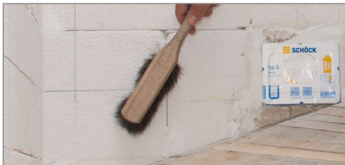
Abb. 123: Staub und lose Teile entfernen
