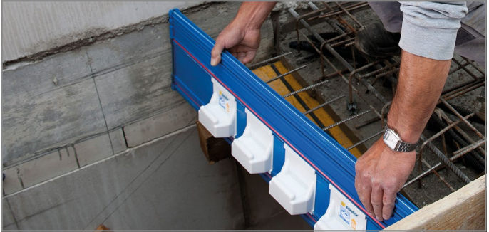
Abb. 88: Tronsole® Typ T einsetzen
