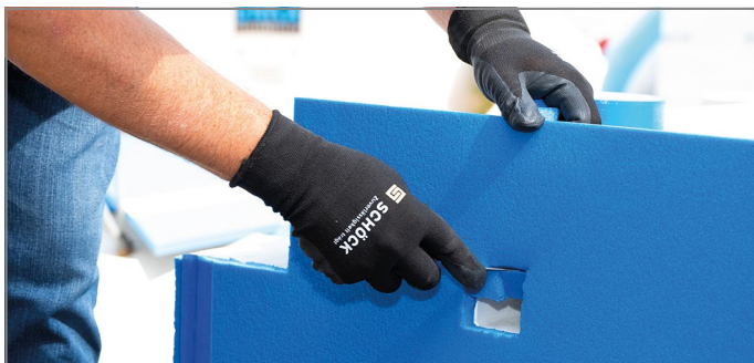
Abb. 34: Geometrie der Podesthülse ausschneiden
