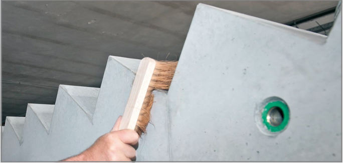
Abb. 135: Staub und lose Teile entfernen
