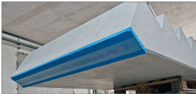
Abb. 112: Tronsole® Typ B aufgeklebt
