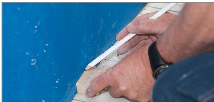
Abb. 125: Unteres Laufprofil von Tronsole® Typ L anzeichnen
