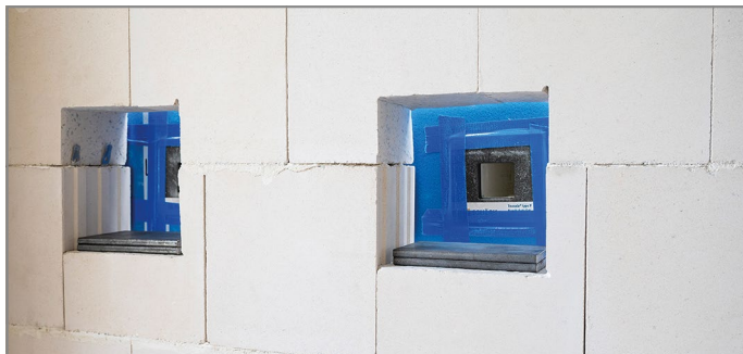
Abb. 39: Podest auf Höhe der Wandaussparungen positionieren
