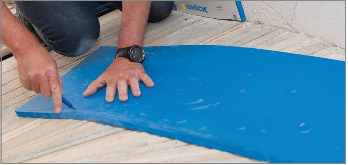
Abb. 126: Unteres Laufprofil von Tronsole® Typ L zuschneiden
