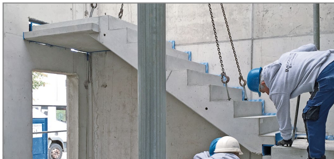
Abb. 54: Treppenlauf positionieren
