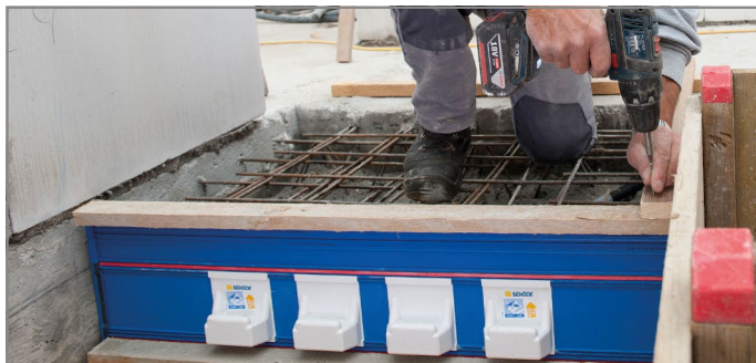
Abb. 92: Tronsole® Typ T abstützen
