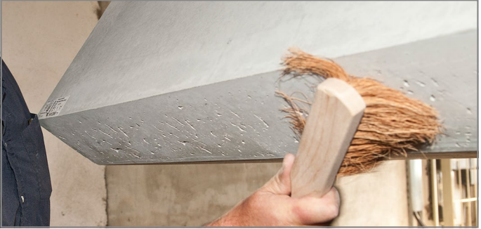
Abb. 108: Staub und lose Teile entfernen
