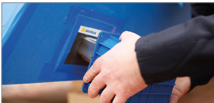
Abb. 79: Wandelement aufsetzen bis Tragelement einrastet
