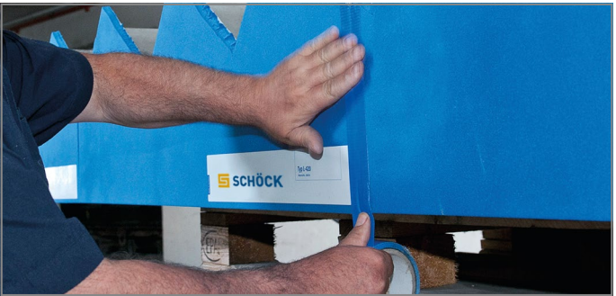
Abb. 142: Stöße von Tronsole® Typ L verkleben
