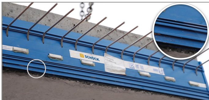
Abb. 101: Nagelleiste unbedingt entfernen
