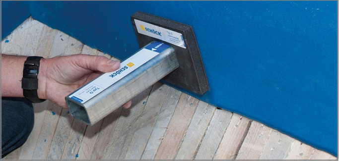
Abb. 62: Tronsole® Typ L ankleben (siehe Seite 72), Brandschutzmanschette und Tragelement positionieren
