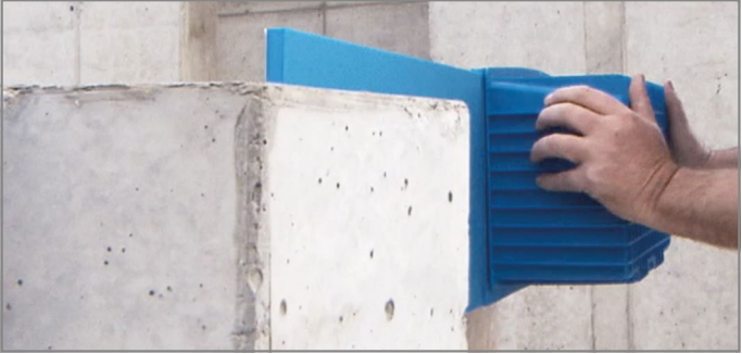
Abb. 51: Tronsole® Typ Z aufstecken
