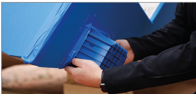
Abb. 80: Wandelement für Einbauzustand waagrecht ausrichten und abkleben
