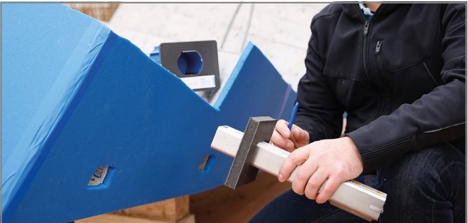
Abb. 73: Tragelement bei Laufhülse positionieren
