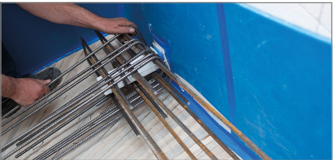
Abb. 70: Erforderliche Zusatzbewehrung verlegen
