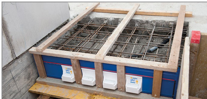
Abb. 93: Vor dem Betonieren
