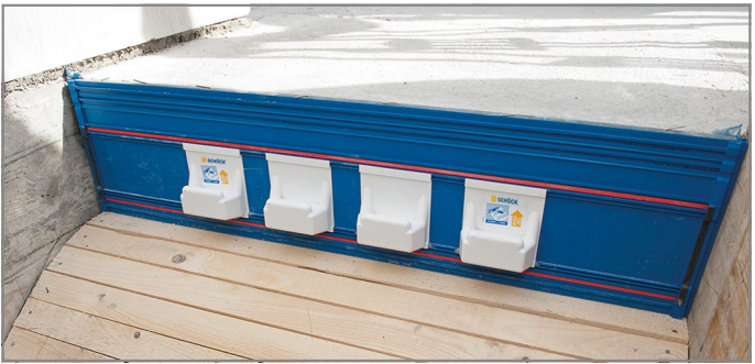
Abb. 95: Oberer Anschluss mit Tronsole® Typ T
