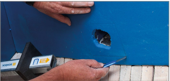
Abb. 64: Geometrie der Brandschutzmanschette ausschneiden
